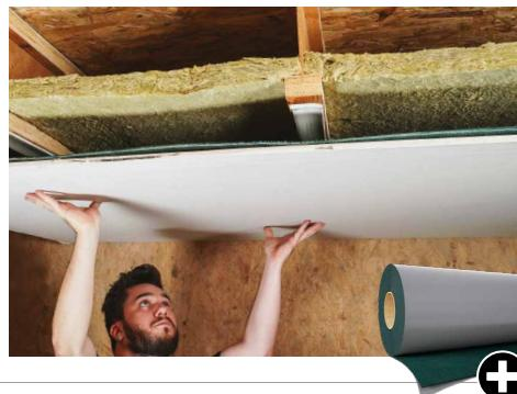
Chiudere la parte inferiore del solaio applicando ai travetti uno strato resiliente **PIANO A**, **SILENT UNDERFLOOR**, **GEMINI**, **GIPS BAND**, **CONSTRUCTION SEALING** aggiungendo massa alla lastra in cartongesso con **SILENT WALL BYTUM** o **SILENT WALL BYTUM SA**
